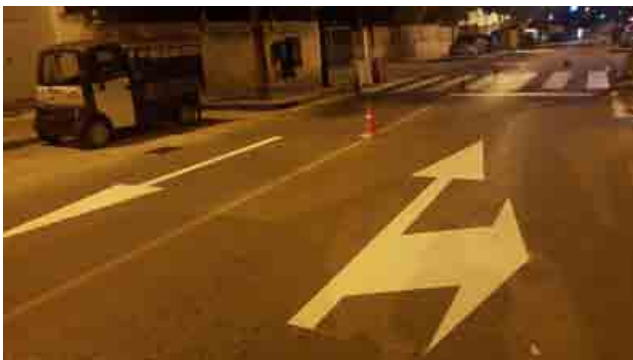
Nuevo paso en c/ José Calderón
