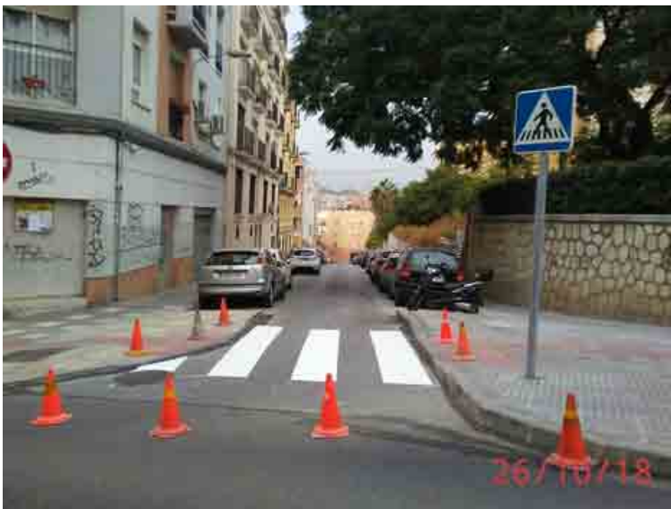
Nuevo paso en c/ Empecinado
