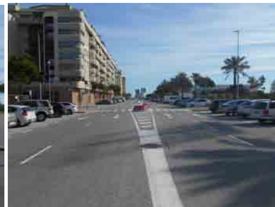
c/ Alicia Larrocha: instalación de mediana de protección en pasos peatones
