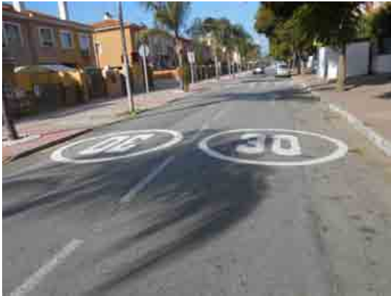
c/ Adonis: instalación de limitación de velocidad
