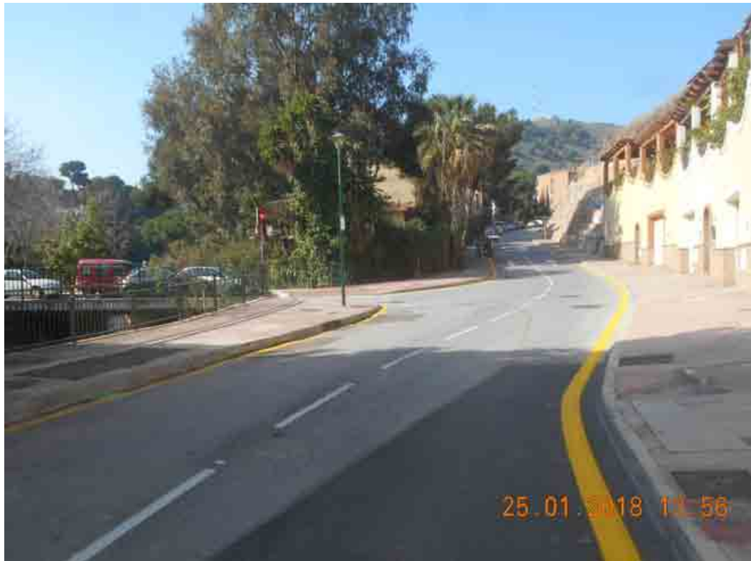
Las Espuelas. Ordenación y repintado completo de la vía. 2018
