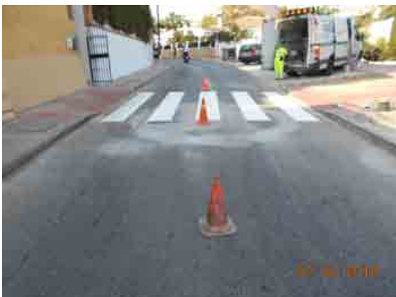
Nuevo paso en c/ Andaluces
