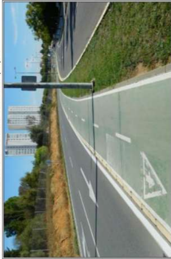
Ilustración 11: Solución de vía en mediana a evitar. Fuente: Elaboración propia.
