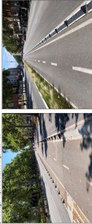
Ilustración 12: Disposición de vías ciclistas en el centro de la calzada. Nótese la continuidad de los separadores (dispuestos a ambos lados) en una configuración de vías ciclista en medio de la plataforma viaria, planificada para acoger viajes ciclistas de largo recorrido
