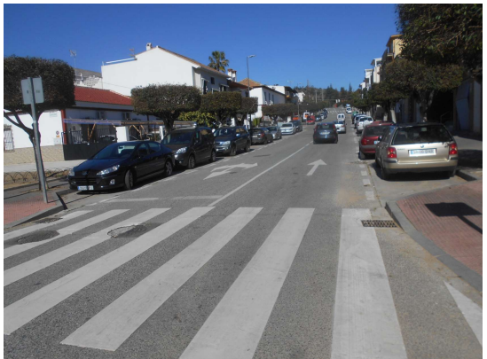
Camino Casabermeja: Repintado completo de la calle
