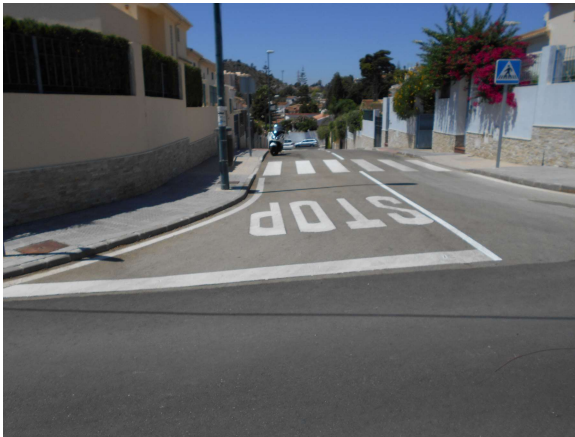
Finlandia: Repintado completo de la calle
