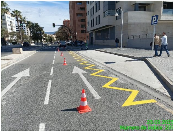
C/ PACIFICO Retirada reserva Patinetes e instalación Nueva Reserva de Motos
