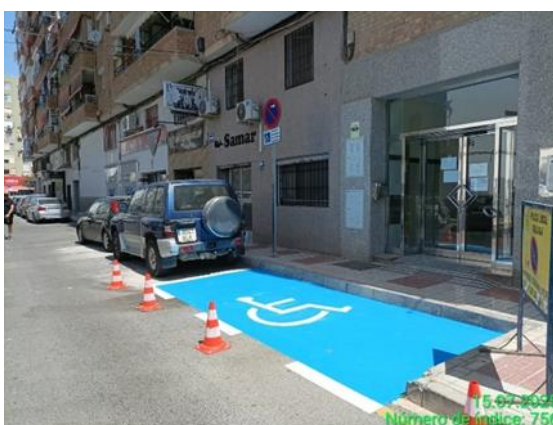
PERDIGUERA Nueva Reserva PMR
