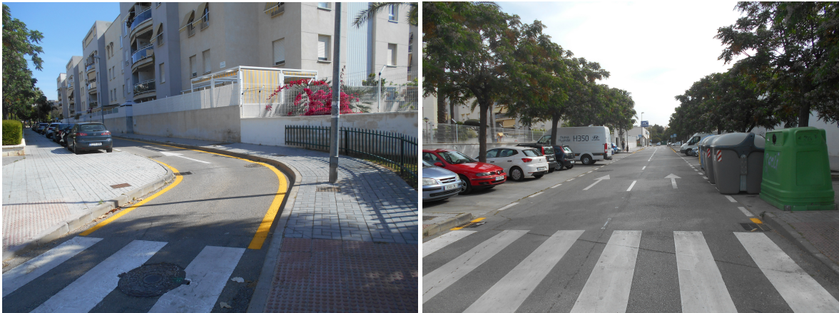
Barriada Puerta de Málaga: Repintado general de la zona
