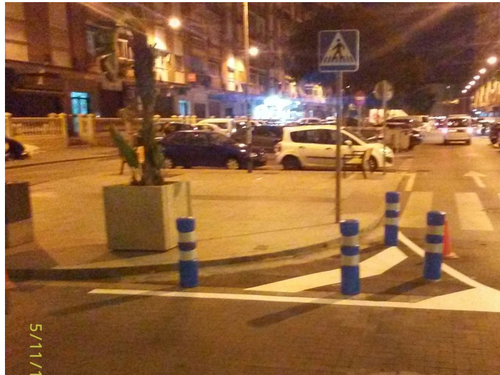
Puerto Oncala: Pintado de isleta y refuerzo con hitos en el cruce con Bv. Adolfo Suárez
