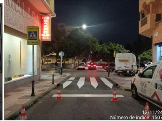
BRÚJULA nuevo paso elevado
