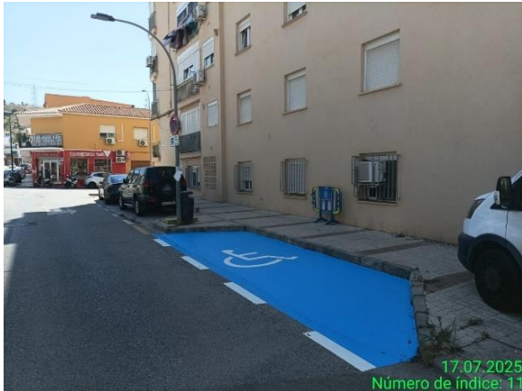
RUISEÑORES Nueva Reserva PMR
