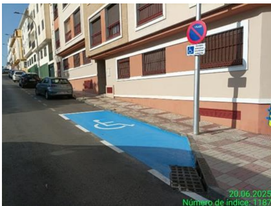
ROJAS Nueva Reserva PMR
